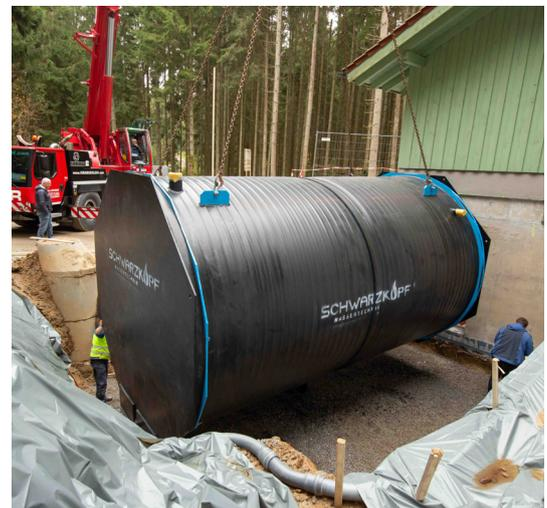
Der PE-Schacht von Schwarzkopf Wassertechnik wird mit einem Kran an seinen neuen Standort befördert.
